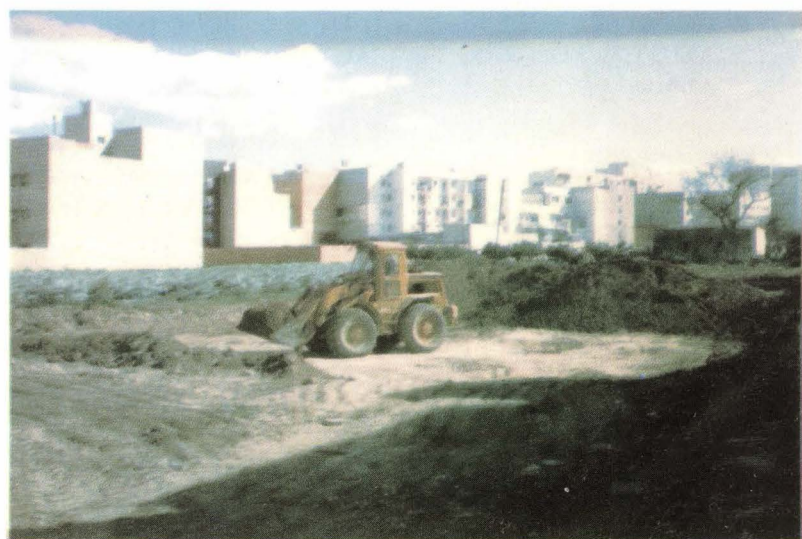
Han empezado las obras de la piscina
