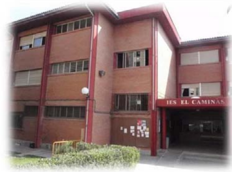
Figura 2.1. Vista de la façana principal de l'institut
