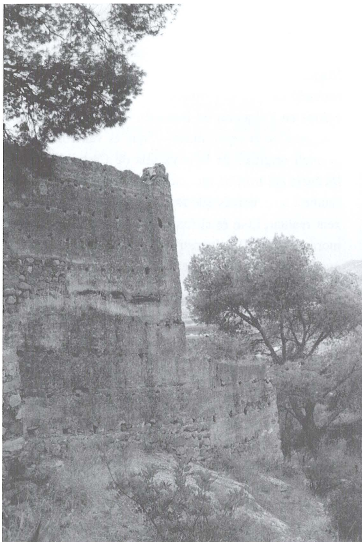
Runes de la façana sud-oest del recinte murat del Castell Vell.
