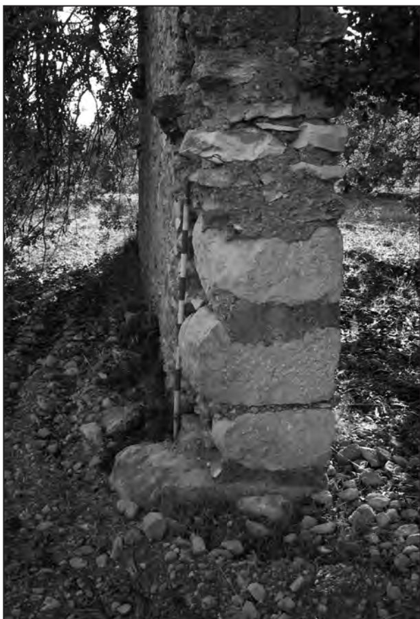
Figura 55. Peníscola. Muro con sillares de expolio en l'Hostal Vell.
