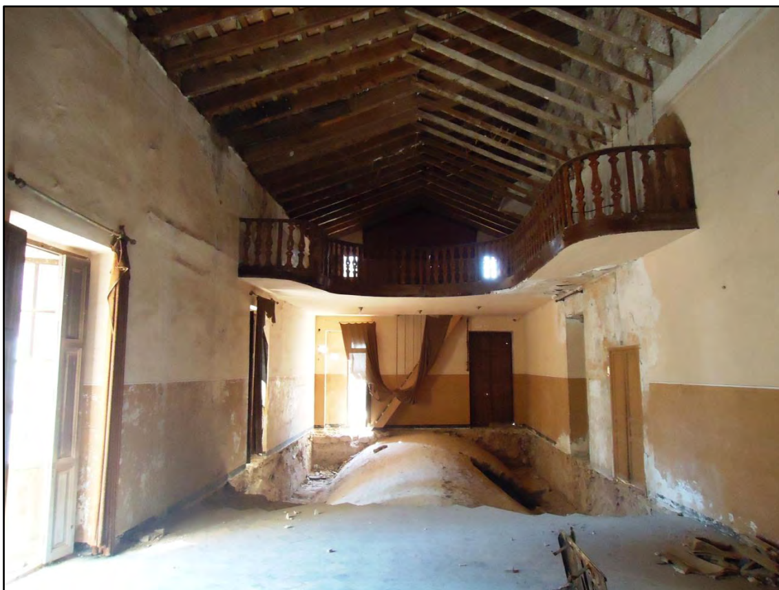
Forjado sobre la bóveda de cañón. Fotografía del autor.
