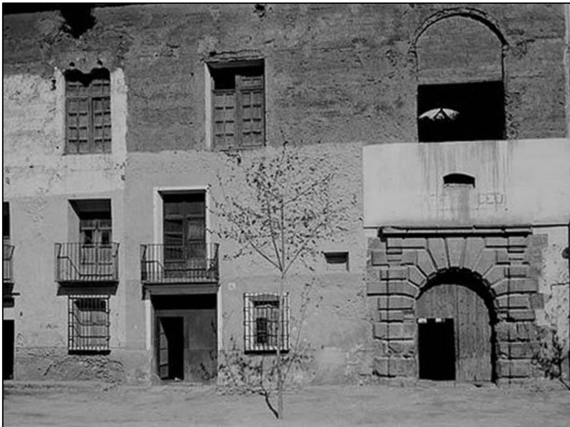
Parte de la fachada originaria. http://www.sierraespadan.es
