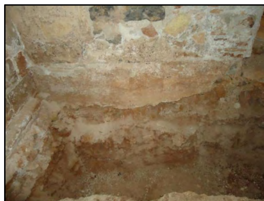
Catas. Cimientos de fachada y torreón sureste. Fotografías del autor.
