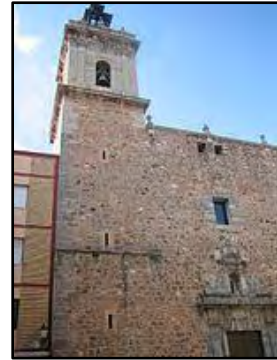
Fachada principal. www.betxi.es
