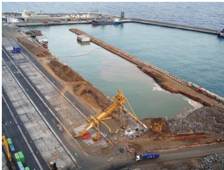
Nueva Base de Contenedores en la Dársena del Este, 2ª Fase
