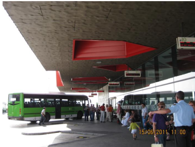
Intercambiador de Padre Anchieta.
