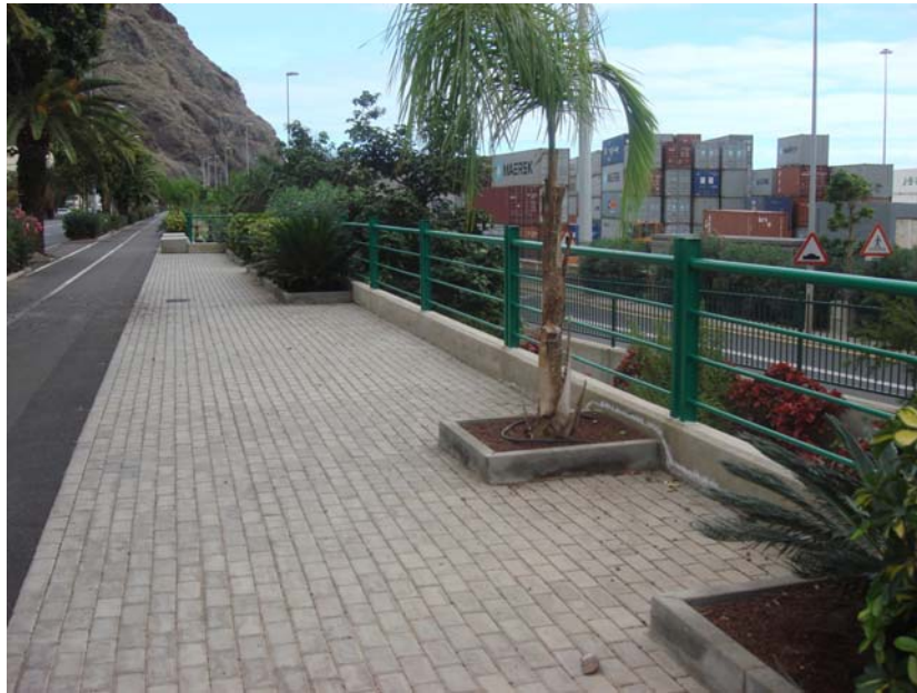
Acondicionamiento de la Vía Litoral frente a María Jiménez y Adecuación Paisajística de la Vía Litoral frente a María Jiménez
