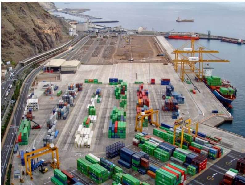
Nueva Base de Contenedores en la Dársena del Este, 2ª Fase y Canalización del Desagüe del Barranco de El Bufadero
