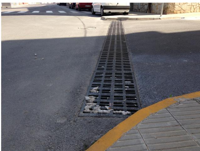
*Imagen 1. Trapa de desagüe para evacuar aguas pluviales hasta acequia.*
