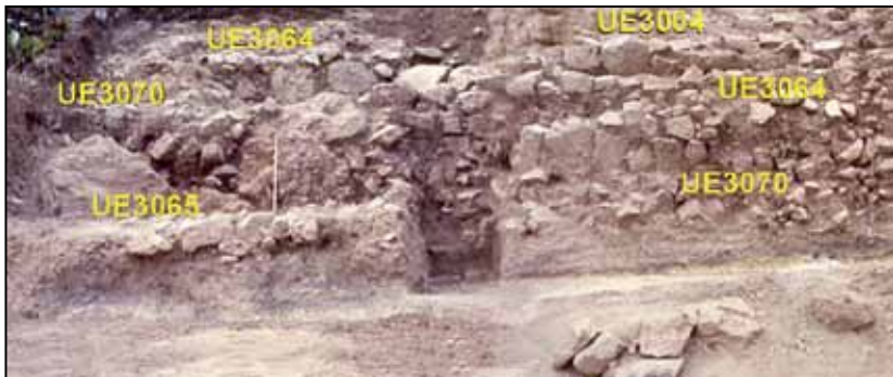
Foto 30. Frontal de la terraza CE23 durante la excavación de 1990. Cuadro Ab/4 del Sector S.
