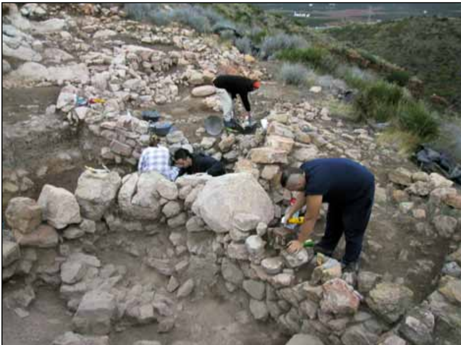
Lámina 2. Primer paso en la consolidación: detección de problemas de la piedra y limpieza de sales y hongos.
