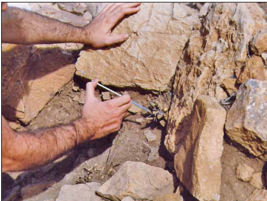
Lámina 4. Detalle del proceso de erradicación de vegetación y raíces incrustadas en los puntos de unión de las piedras de los muros.
