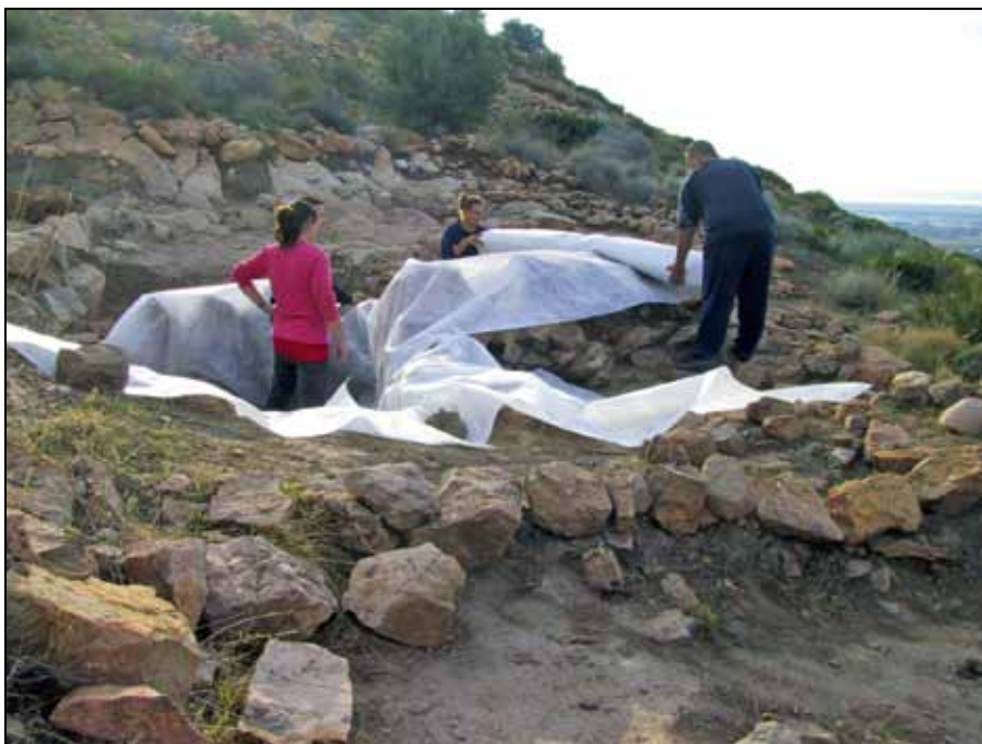
Lámina 8. Terminada la consolidación los muros se recubren con geotéxtil.
