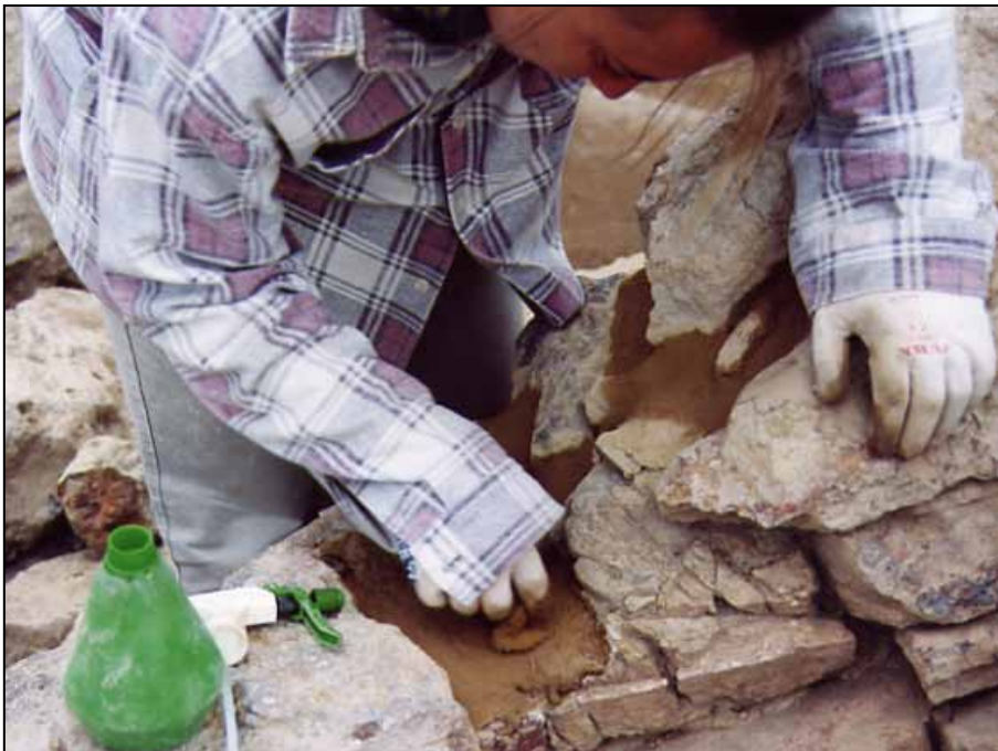
Lámina 6. Detalle de la aplicación de los morteros.
