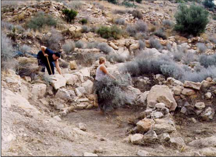
Lámina 1. Inicio de los trabajos de consolidación con el desbroce de la superficie excavada. Obsérvese la proliferación de vegetación después de tres años.
