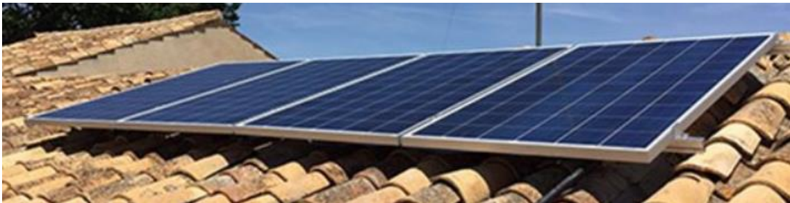
Ilustración 63. estructura cubierta tejas empresa Autosolar
