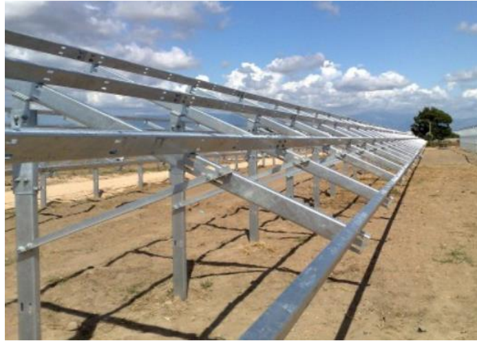
Ilustración 67. Soporte monoposte sin obra civil de la empresa Industrias Duero
