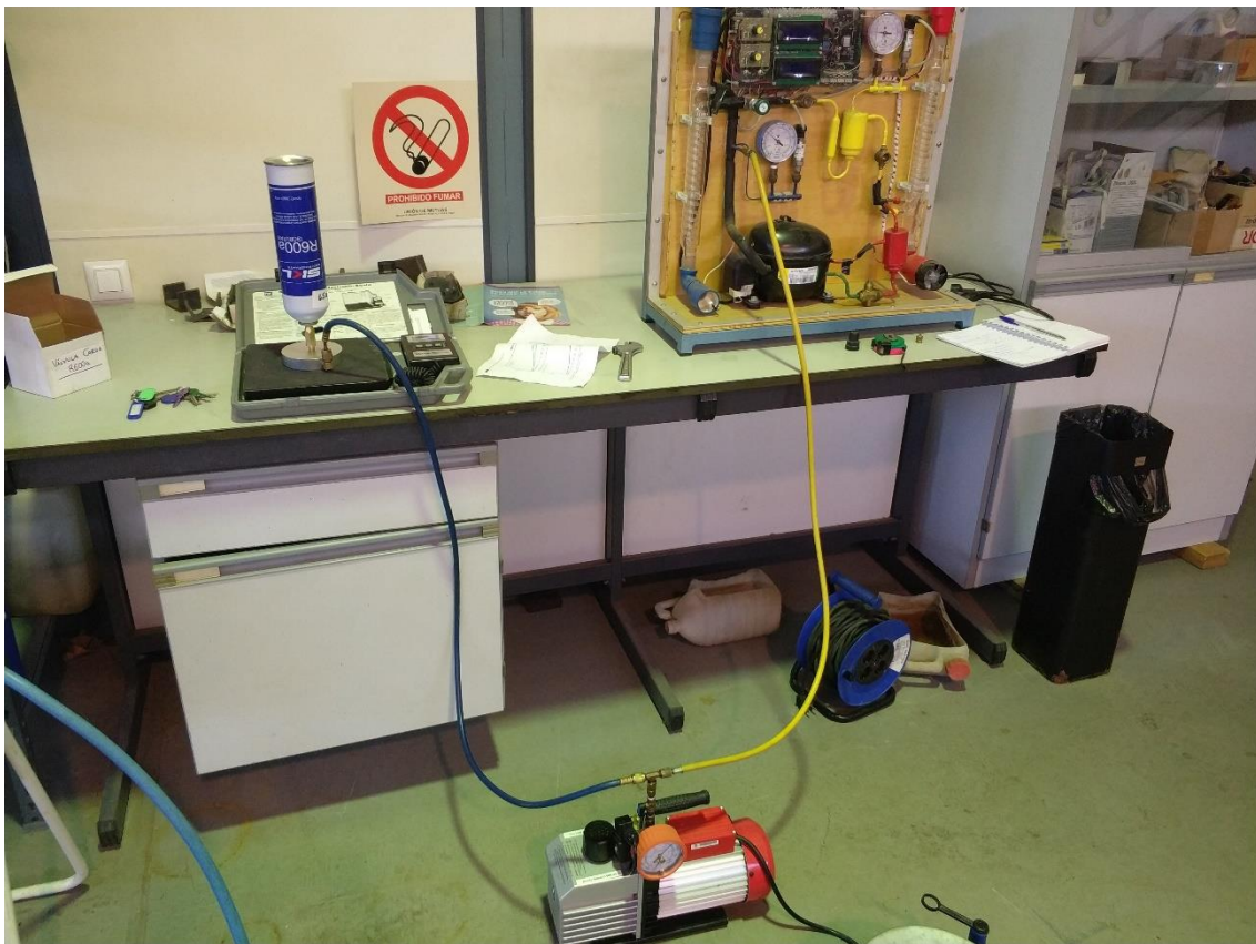
Ilustración 46 - Imagen de la carga del refrigerante en el circuito
