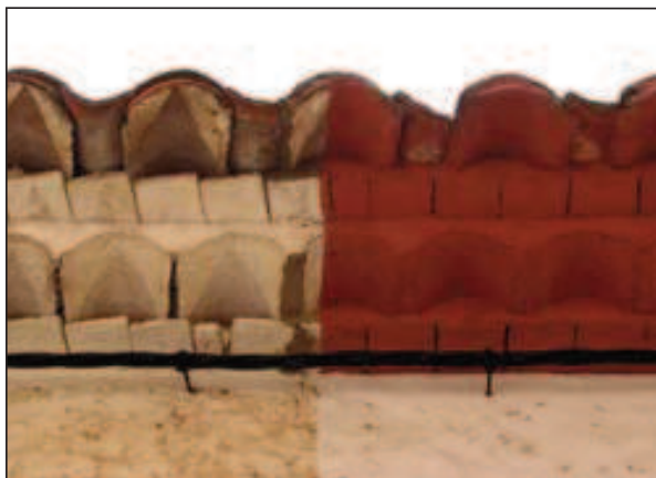
Figura 08. Volada emblanquinada una part i tota pintada l'altra
