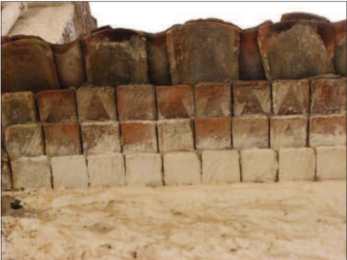
Figura 07. Volada emblanquinada a mitges
