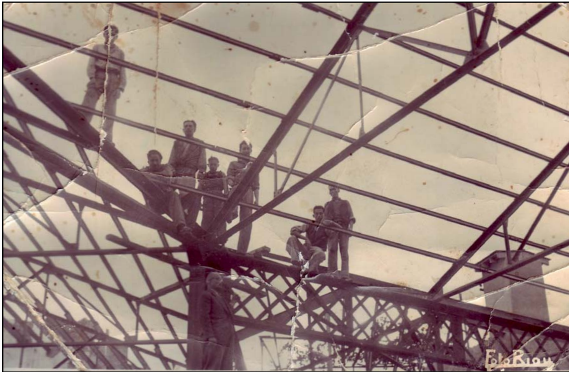
252. Treballadors de Juan Vicent (Juanito Mariana) construint el magatzem de garrofes de Joaquin Agustina. Any 1948 Propietat: Pepe "el Cantó"
