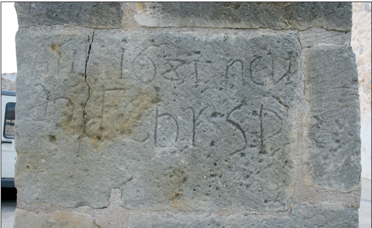
Figura 11. Detall del brancal dret de l'entrada al placet de l'església, la inscripció recorda la nevada de 1681 amb més d'un metre de grossària.
