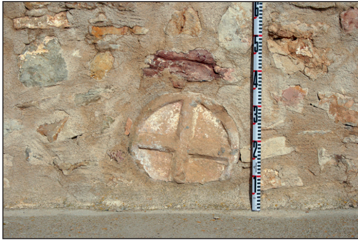
1. Estela discoïdal reaprofitada per al mur de tanca del placet.
