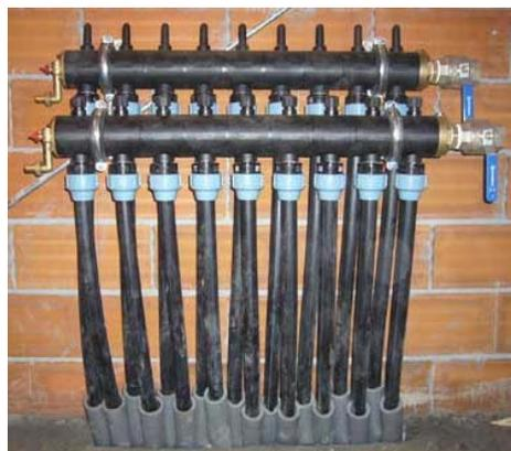
Fig 31. Colector geotérmico.
