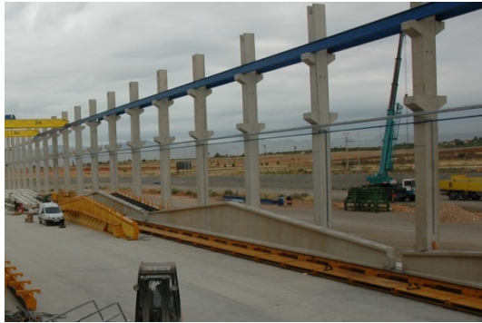
Figura 4.31: Desmoldeo de vigas delta. Ref. PAVI
