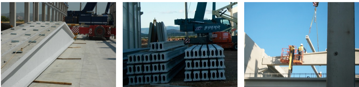
Figura 4.42: Posicionar anclaje en viga, acopio y montaje correas. Ref. PAVI
