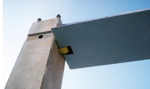
Figura 4.60: Mensulas metálica Unión pilar-forjado, Ref. PEIKKO
