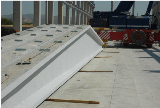
Figura 4.36: Acopio viga. Ref. PAVI
