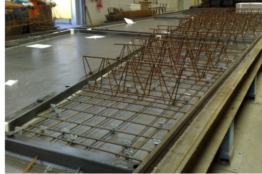
Figura 4.24: Colocación del armado del muro doble (mallazo, armadura refuerzo y celosía) Ref. PAVI
