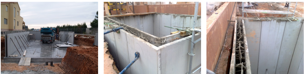
Figura 4.44: Acopio, posicionamiento, hormigonado del interior del muro. Ref. PAVI
