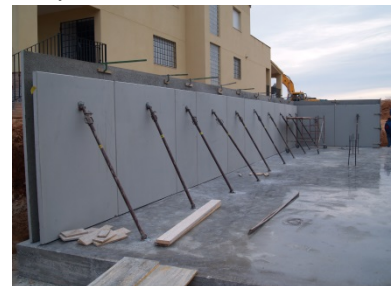
Figura 5.1: Medidas preventivas durante el montaje de elementos prefabricados, Ref. PAVI
