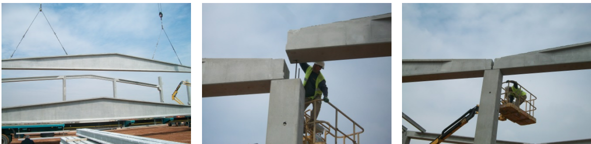
Figura 4.41: Manipulación, posicionamiento y montaje viga. Ref. PAVI
