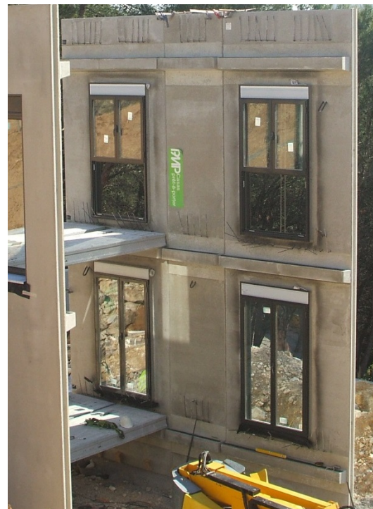
Figura 4.62: Mensulas de hormigon en panel Unión panel-forjado, Ref. PMP.
