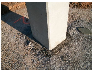
Figura 4.45: Unión con caliz, zapata-pilar, Ref. PAVI
