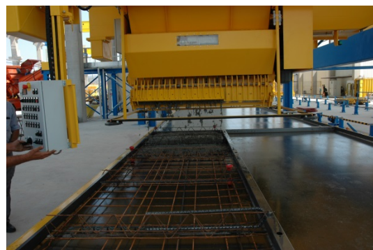
Figura 4.26: Vertido de hormigón sobre la mesa mediante la tolva de distribución. Ref. PAVI
