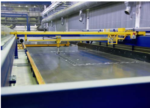
Figura 4.21: Replanteo de la pieza y la armadura del panel mediante el plotter. Ref. EBAWE
