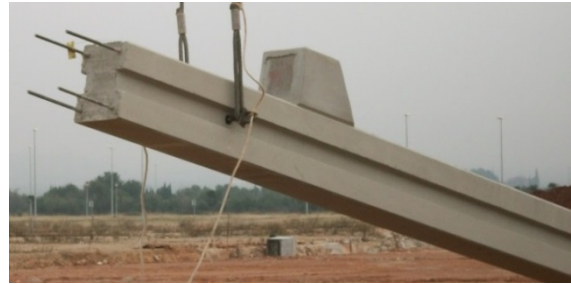
Figura 4.3: Pilar con galce, Ref. PAVI
