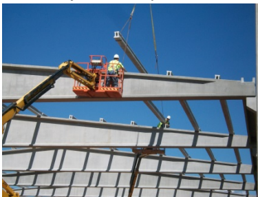
Figura 5.1: Medidas preventivas durante el montaje de elementos prefabricados, Ref. PAVI
