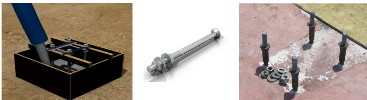
Figura 4.48: Colocación tornillos de anclaje, Ref. PEIKKO
