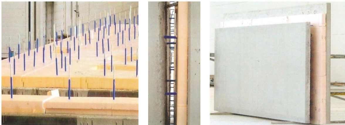
Figura 4.13: Muro doble sin puente térmico, Ref. PAVI
