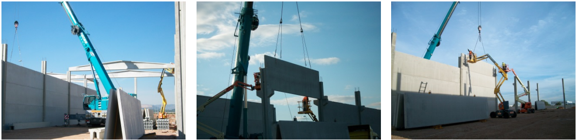
Figura 4.43: Acopio, posicionamiento y estado final panel entre galces. Ref. PAVI
