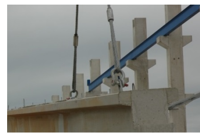
Figura 4.35: Anilla de elevación vigas. Ref. PAVI
