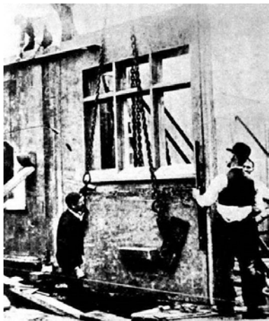
Figura 3.2: Montaje de paneles de hormigón
