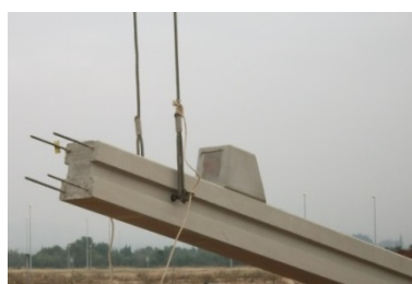
Figura 4.34: Tubo elevación pilares. Ref. PAVI
