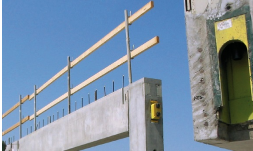
Figura 4.59: Mensulas metálicas Unión pilar-viga, Ref. PEIKKO
