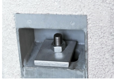
Figura 4.51: Proceso montaje pilar, Ref. PEIKKO
