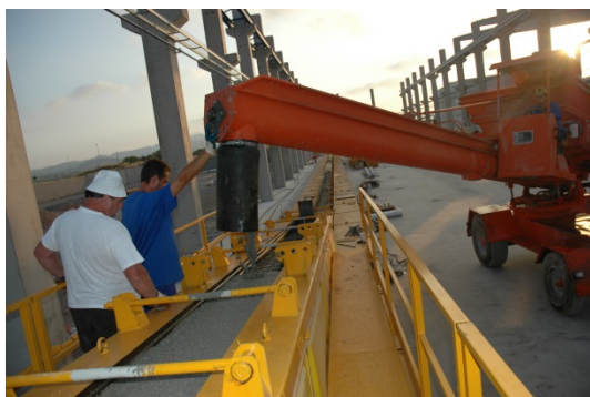
Figura 4.25: Vertido de hormigón en molde de viga delta por medio de cubo de hormigonado. Ref. PAVI
