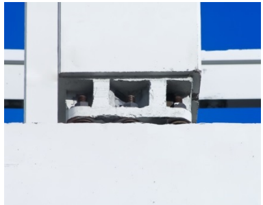
Figura 4.49: Proceso montaje pilar, Ref. PEIKKO
