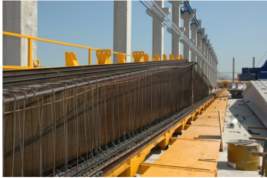
Figura 4.23: Colocación del armado de la viga delta sobre el molde. Ref. PAVI
