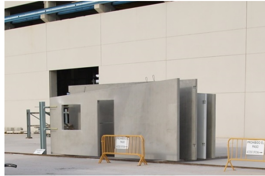
Figura 4.37: Acopio paneles de cerramiento. Ref. PAVI
