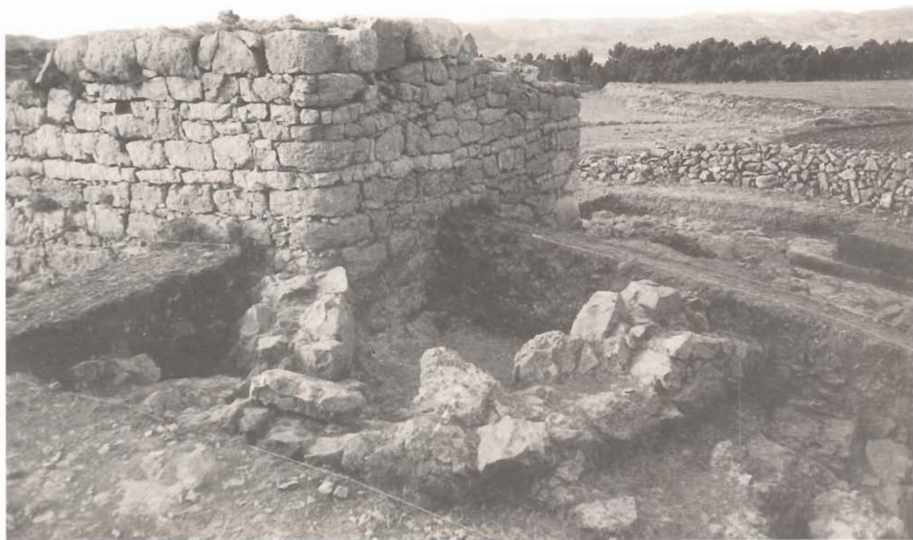
Foto1. Angle nord/est amb el mur de contrafort entre els paraments de la torre i el peristàl·lit.
