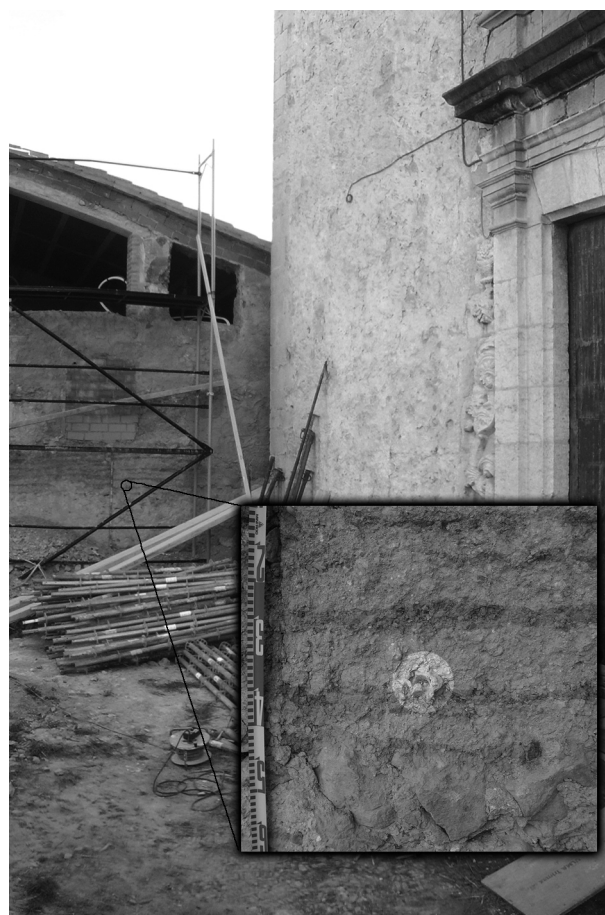
Figura 11. Detall d'una vèrtebra humana al tapial de la façana sud de les antigues escoles d'Hortells.
