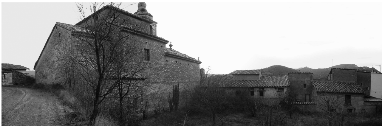
Figura 4. Imatge del costat nord de l'església i de les antigues escoles (el primer edifici a la dreta el temple).
