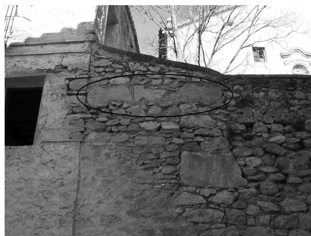
Figura 7. Imatge de dos esteles funeràries medievals amortitzades al mur de contenció del placet de l'Església.
