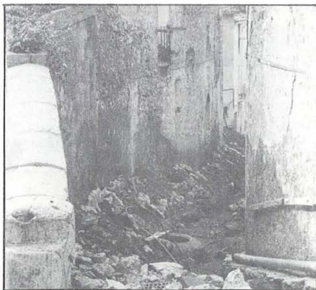
BORRIOL TIENE UN ALCANTARILLADO NUEVO
