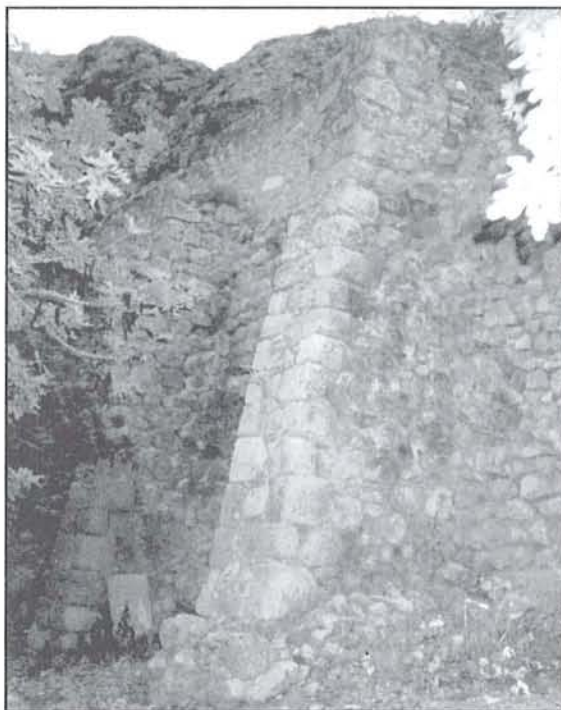
Contraforts del Palau.
