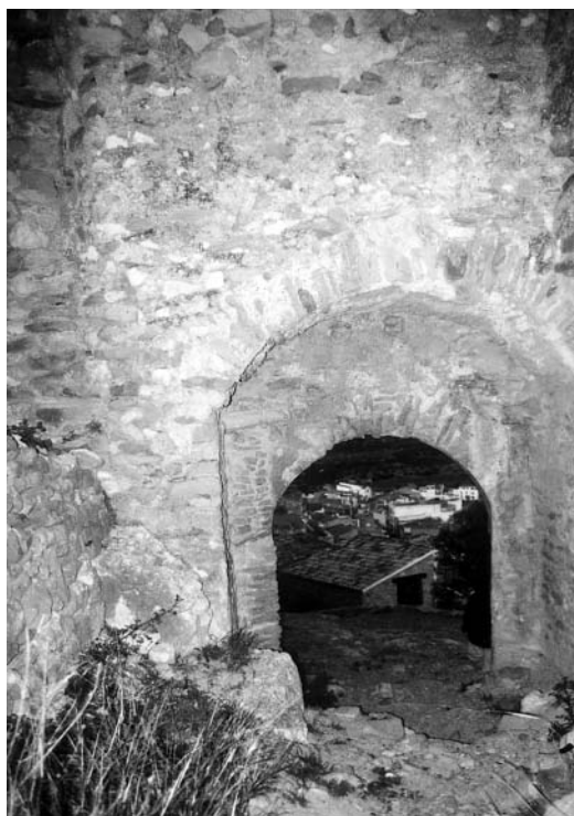
Dos aspectos del acceso sur.
