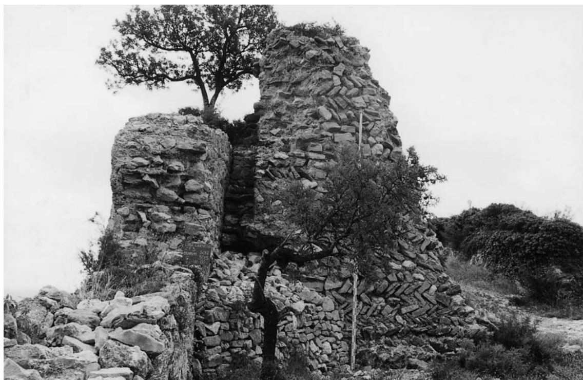
Estructuras de la fase feudal de Montesa, con aparejo en espiga y troneras.
