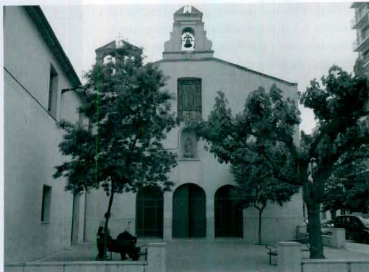
Fachada del Convento y Parroquia de los Franciscanos.
