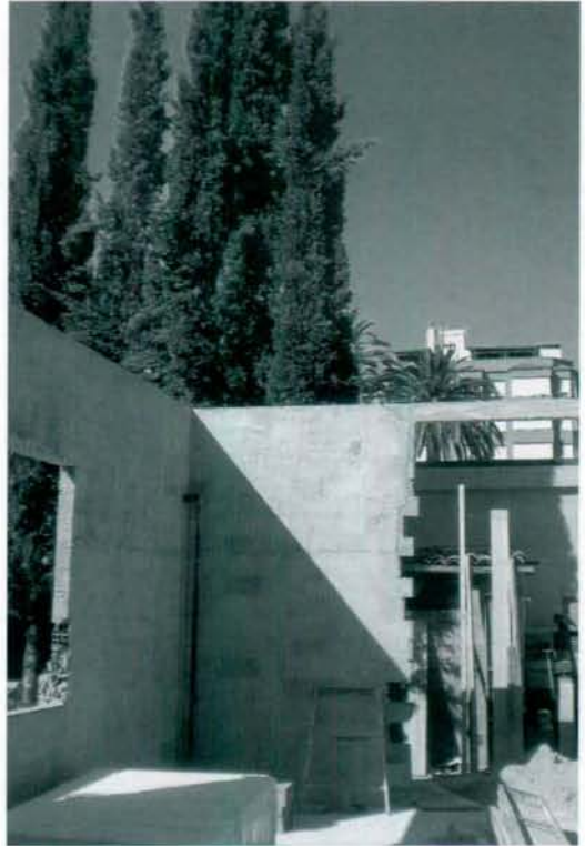
Construcción de la sala donde se guardará la carroza de San Pascual.
