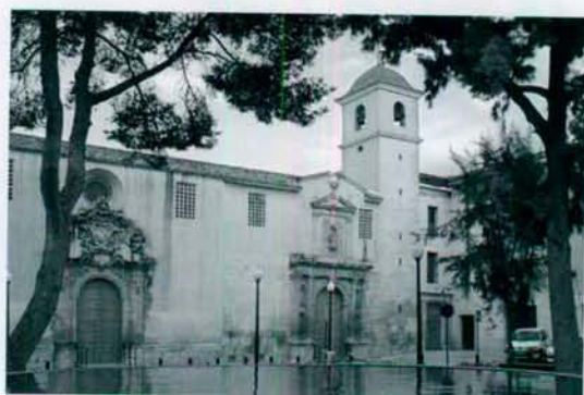
Iglesia Convento del Carmen de Orihuela.
