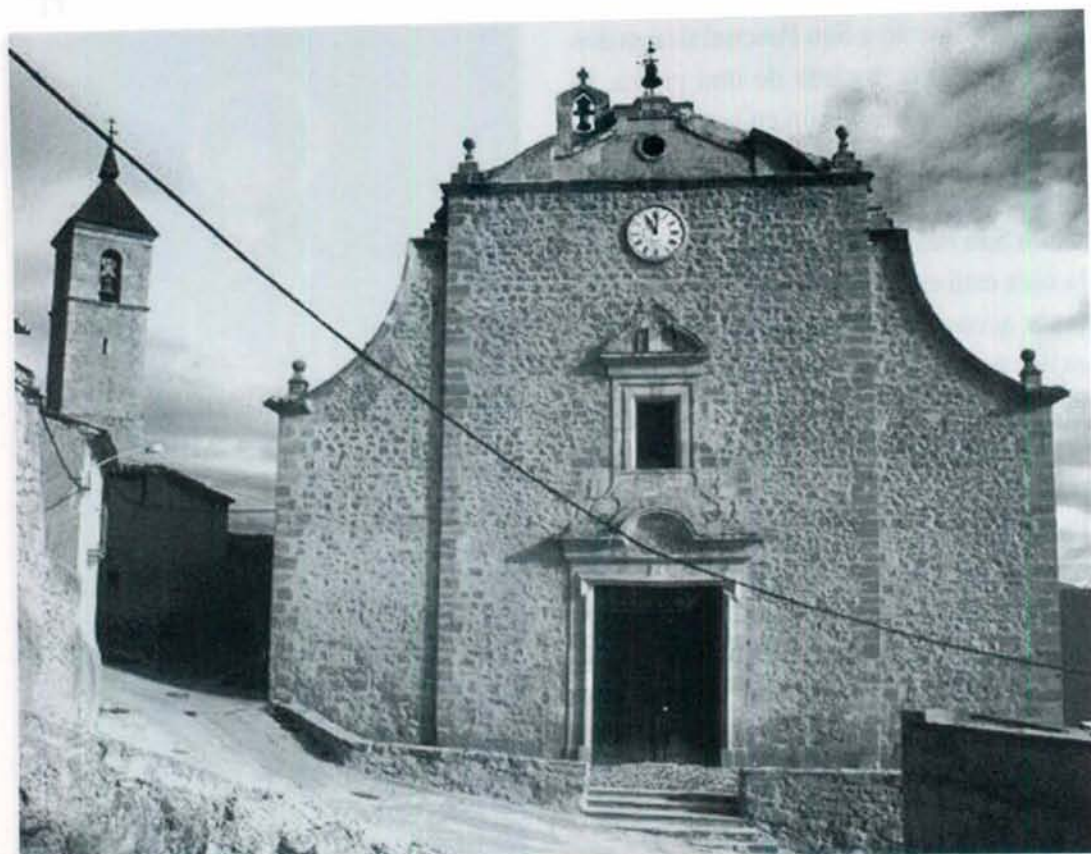
FACHADA DE LA IGLESIA PARROQUIAL DE SAN PASCUAL EN TORREHERMOSA
