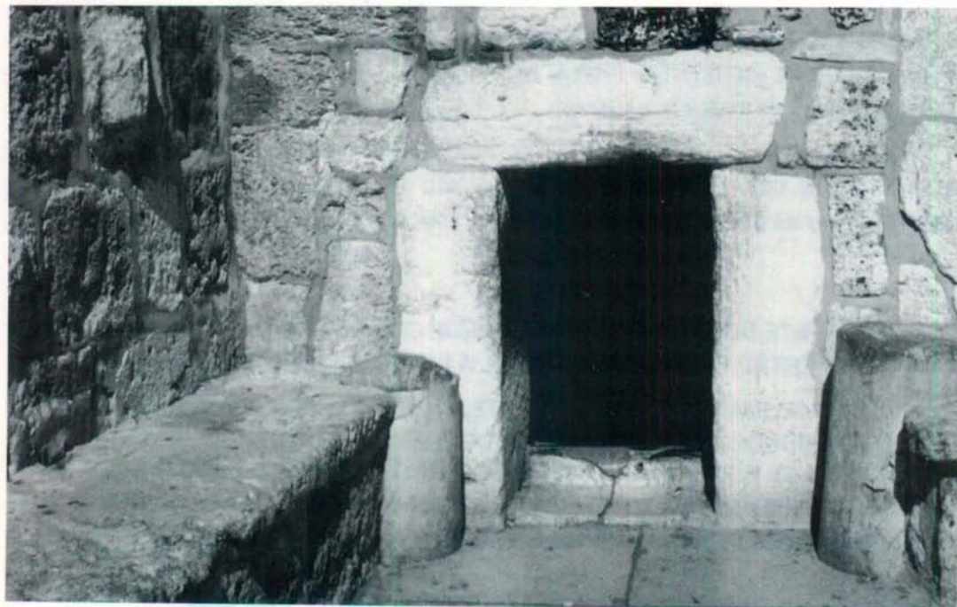
PUERTA DE ENTRADA A LA CRUJA DE LA NATIVIDAD
