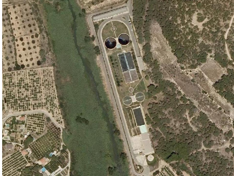
Figura 3: fotografía aérea de una EDAR para unos 12.000 habitantes-equivalentes
