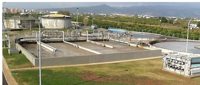
Figura 4: vista general de una EDAR
