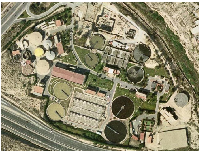
Figura 1: fotografía aérea de una EDAR para más de 150.000 habitantes-equivalentes
