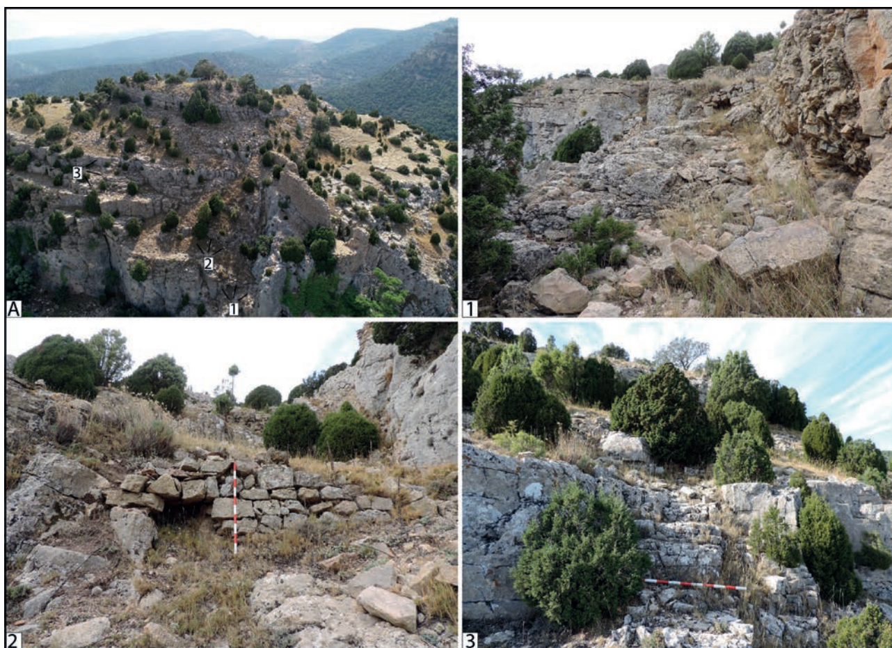
Figura 11. Rampa de acceso al Castell de El Boi. Inicio de rampa en zigzag (1); muro de contención de la rampa de acceso (2); escalera tallada en la roca (3).
