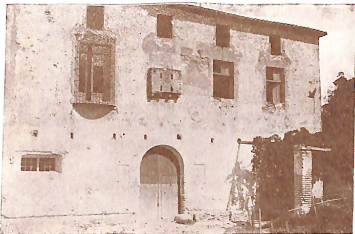
Alquería en ruinas
