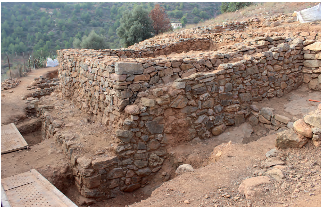
Figura 9. Torre B durant el procés de conservació – restauració, des de l'extrem NE.
