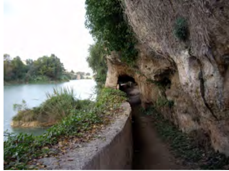
Sèquia de les Argamasses
