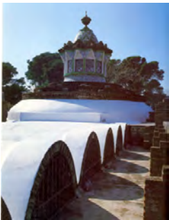
Coberta de les cavallerisses Pavellons de la finca Güell.
