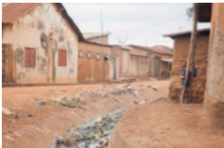
Imagen 13: Alcantarillado superficial. Fuente: OAN International
