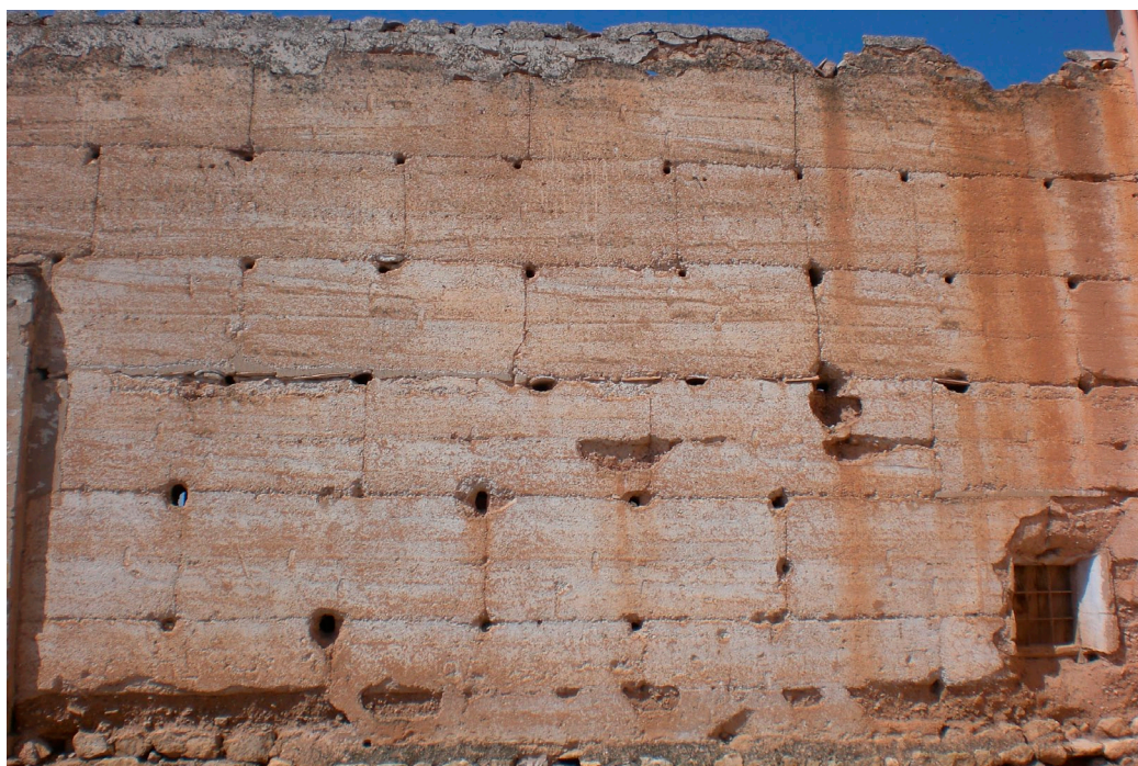
Font material. Paret de tàpia construïda als anys 1940-1950 (J. Aparici)
