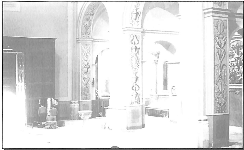
La parte izquierda, entrando, del Templo, ya cuenta con el nuevo piso de mármol, respetándose las losas funerarias.
