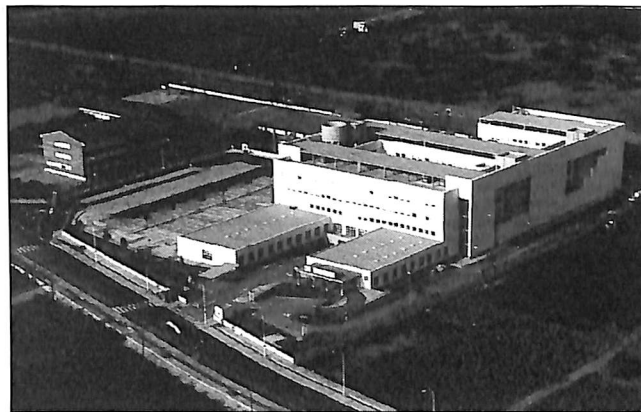
El Hospital Comarcal ya está en funcionamiento en su primera fase.
