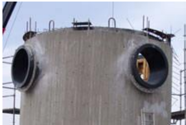
Figura 14. Imagen de una torre de captación de hormigón. Fuente: página web de la planta desaladora de Valdelentisco. Ministerio de Agricultura, Alimentación y Medioambiente. Gobierno de España.
