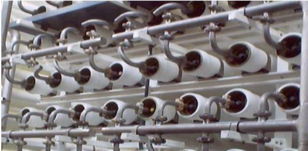
Figura 26. Conexión de los bastidores de membranas. Fuente: Documento de Fundamentos, Diseño y Mantenimiento. Bastidores de Membranas.( www.desalación.org ) de Jose Luis Pérez Talavera.
