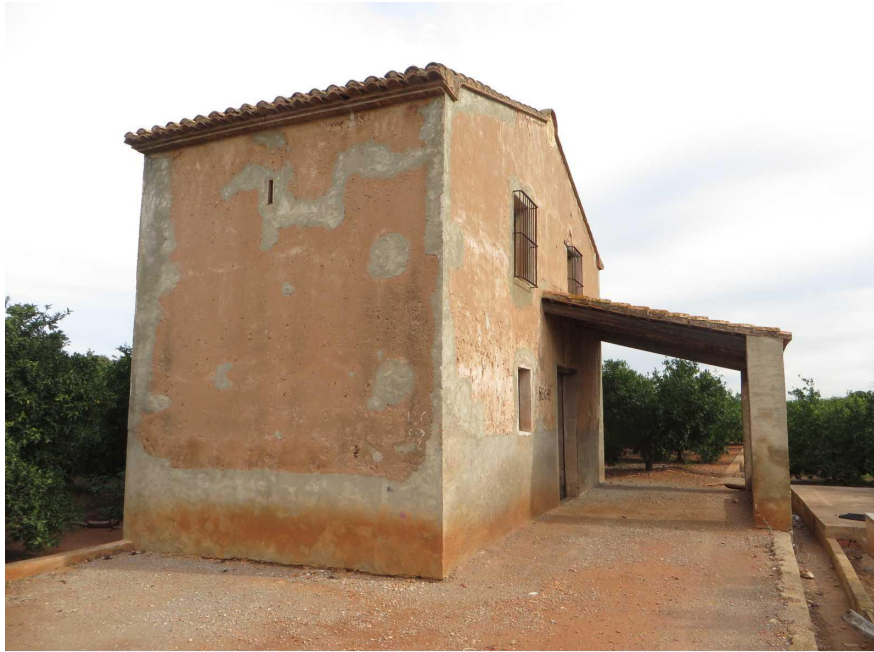
Figura 3: Vista de la construcción presente en la parcela
