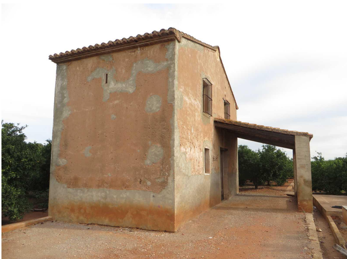
Figura 13: fachada de la construcción presente en la parcela
