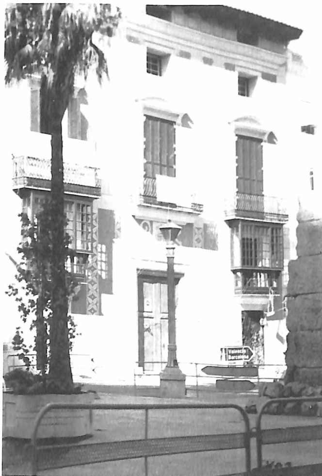
El nuevo Ayuntamiento ya ha abierto sus puertas al público tras la remodelación del edificio
