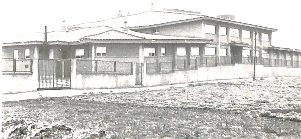
Per fi obrirà les portes el Centre Ocupacional
