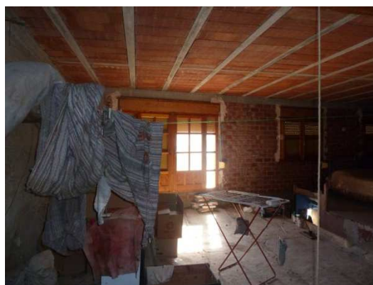
FOTOGRAFÍA 06. Estructuras y acabados
