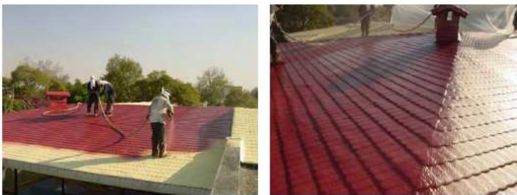
IMAGEN 31.Rehabilitación de cubierta con proyección de espuma de poliuretano. Fuente GREEV
