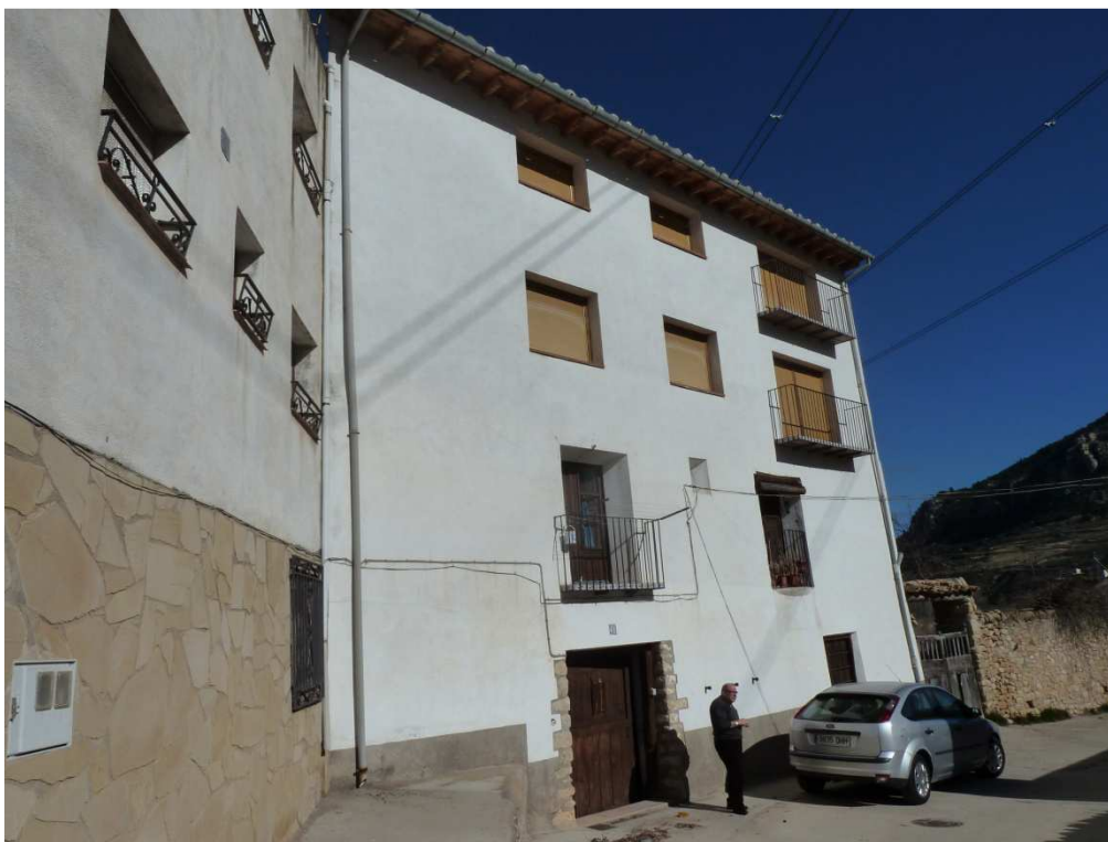
Fachada principal.C/Petra Palos
