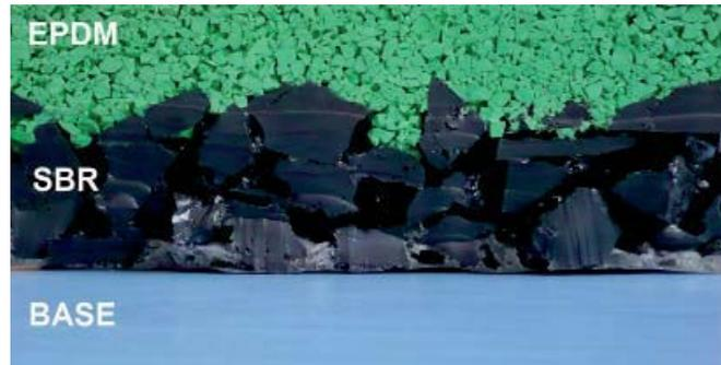
*Ilustración 19. Sección Pavimento continuo de caucho (PVJL-03)*
