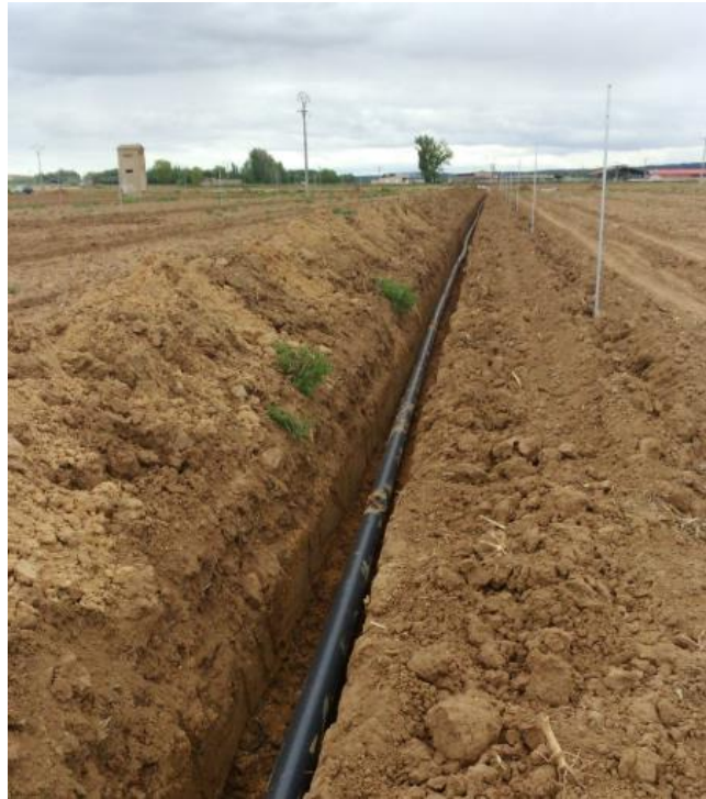
Ilustración 20 Tubería de PVC en zanja para posterior soterramiento.
