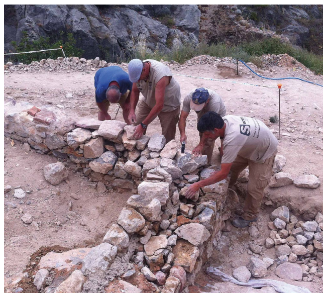
Treballs de consolidació de les estructures
