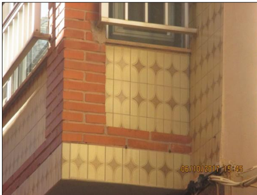
*Detalle del revestimiento cerámico de 15x7,5 cm en una fachada.
