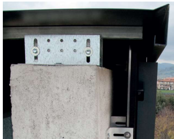
Figura 54. Apertura superior, (Fuente: LaminaM)
