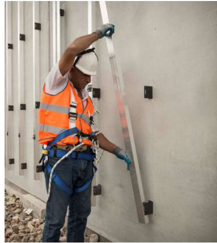
Figura 48. Colocación perfil “T”, (Fuente: LaminaM)
