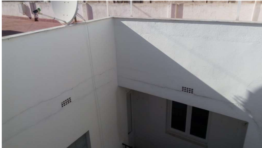
Figura 20. Ventilación en patio luces, (Fuente: autor).
