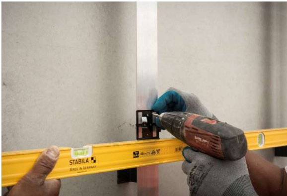
Figura 49. Replanteo “clip”, (Fuente: LaminaM)
