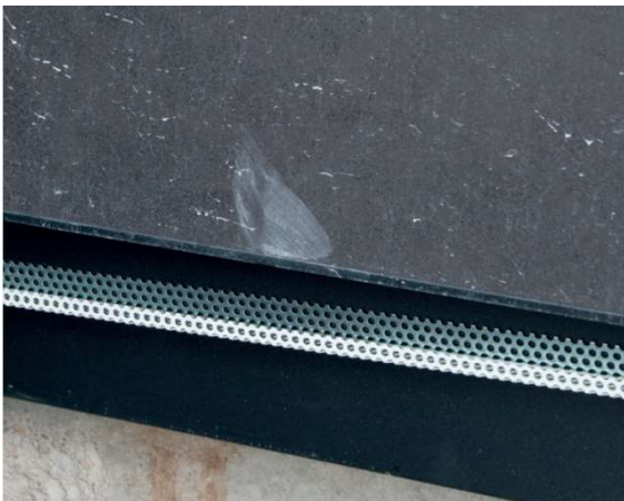
Figura 53. Apertura inferior, (Fuente: LaminaM)
