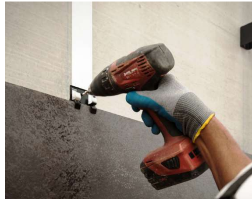
Figura 50. Colocación “Clip”, (Fuente: LaminaM)
