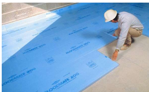
Figura 65. Ejemplo de colocación aislante térmico XPS, (Fuente: www.imperfel.com )
