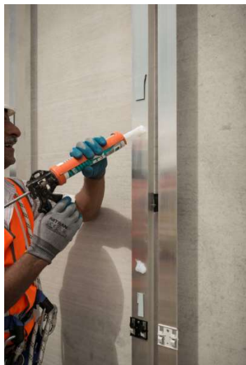
Figura 51. Colocación adhesivo, (Fuente: LaminaM)
