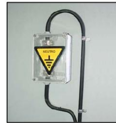
Figura 3.13: Caja de Seccionamiento de Neutro
