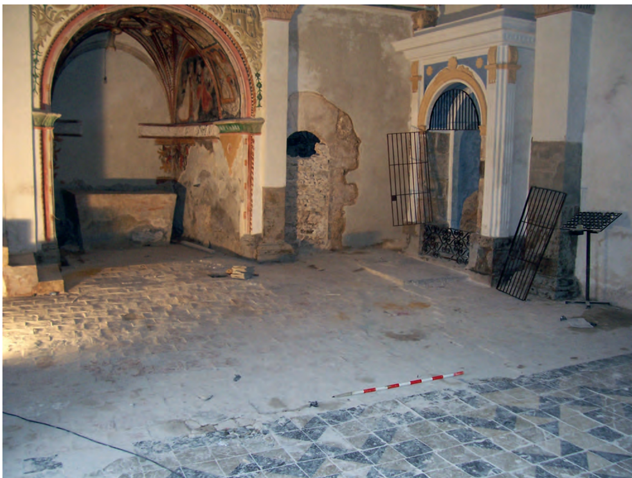
Figura 6. Vista interior de la nau abans d'excavar.
