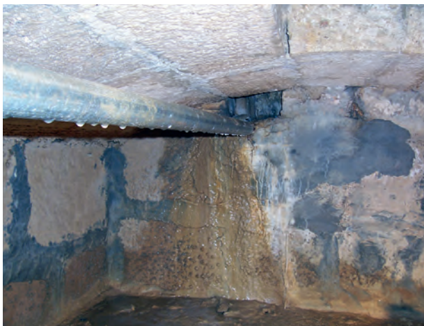
Figura 12. Detall de la cisterna interior que vessa aigua a l'abeurador extern (UE 1014).
