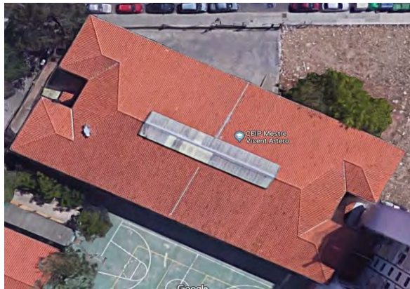
Imagen 23. Cubierta del Edificio 1
