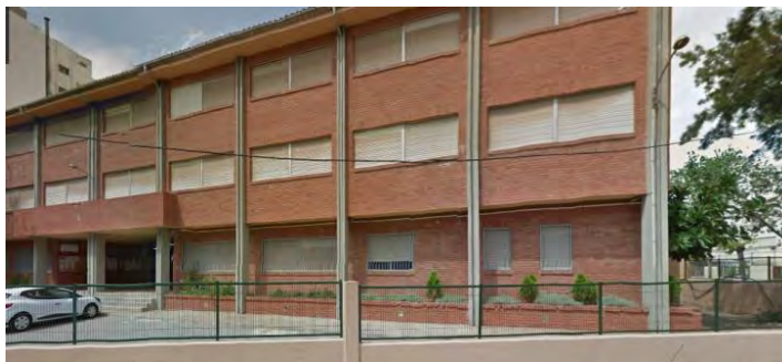
Imagen 5. Edificio 1- Edificio de primaria
