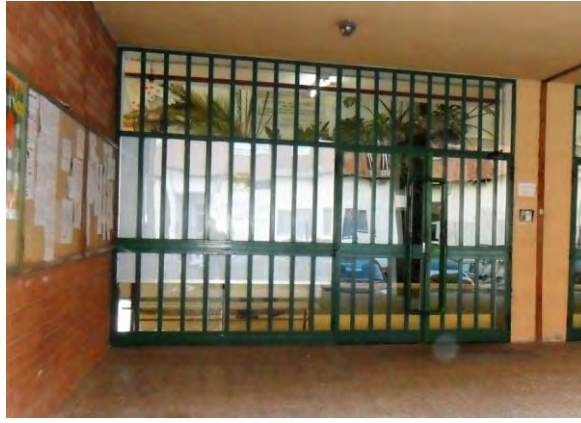
Imagen 26. Puertas acceso principal Edificio 1
