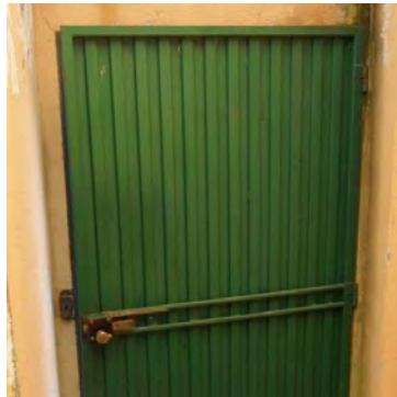
Imagen 27. Puertas acceso secundario y aseos exteriores Edificio 1
