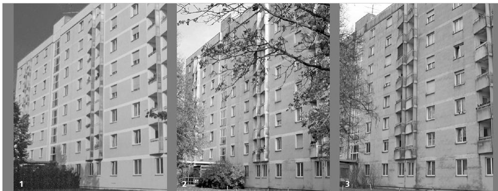
Imagen 2-1. 1-3 Fachada oeste de la propiedad no. 16 en Múnich, 4 años (izquierda), 19 años (centro) y 29 años (derecha) después de la aplicación del sistema SATE, sin renovación intermedia de la fachada. Fuente: IBP (2015)
