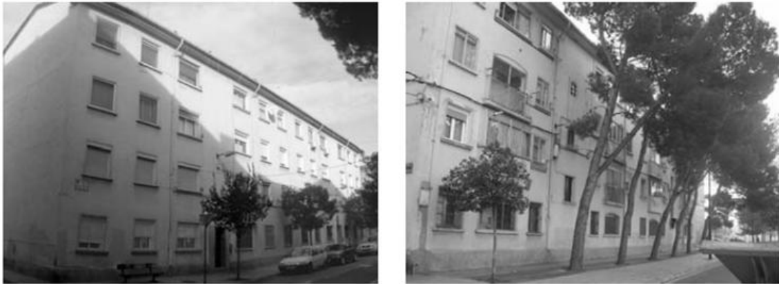
Figura 3-8. Fachada Este Pral. (izq.) y Fachada Oeste (dcha.). Fuente: IDAE.
