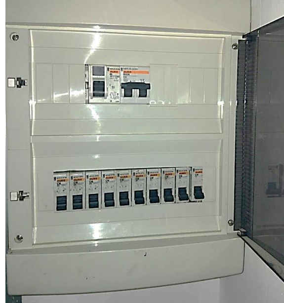
Fig. 37 (Font pròpia): Quadre de comandament elèctric dels motors. En la part superior hi ha el diferencial i magneto tèrmic general i baix els diferents magneto tèrmics a mode d'interruptor de cada grup de motors.
