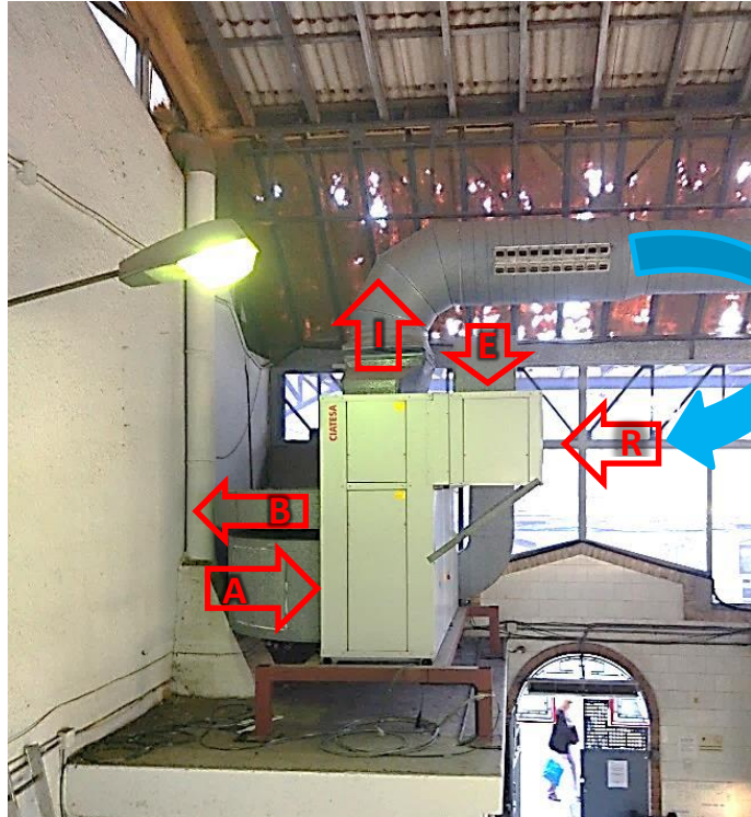
Fig. 41 (Font pròpia): Fotografia de la màquina 1 de l'equip de climatització ubicada sobre la sala de les deixalles amb la circulació de l'aire grafiada.
