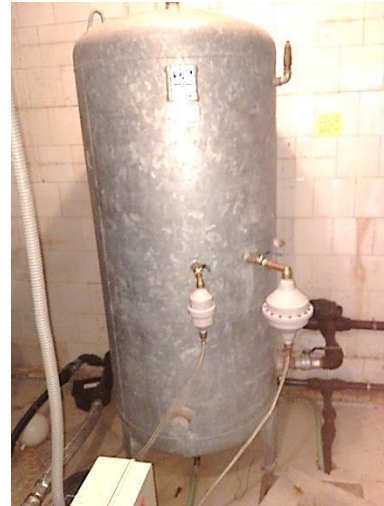
Fig. 42, 43 i 44 (Font pròpia): Fotografies de l'equip de pressió per a l'aigua potable del Mercat. Es tracta de dues bombes de pressió de 2'7 kW cadascuna funcionant en paral·lel i de forma alternativa. També consta de calderí de 100 L i depòsits de polietilè amb una capacitat total aproximada de 2000 litres.
