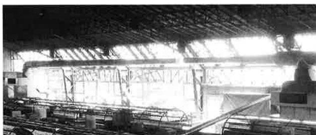
Vista interior de la cristalera
