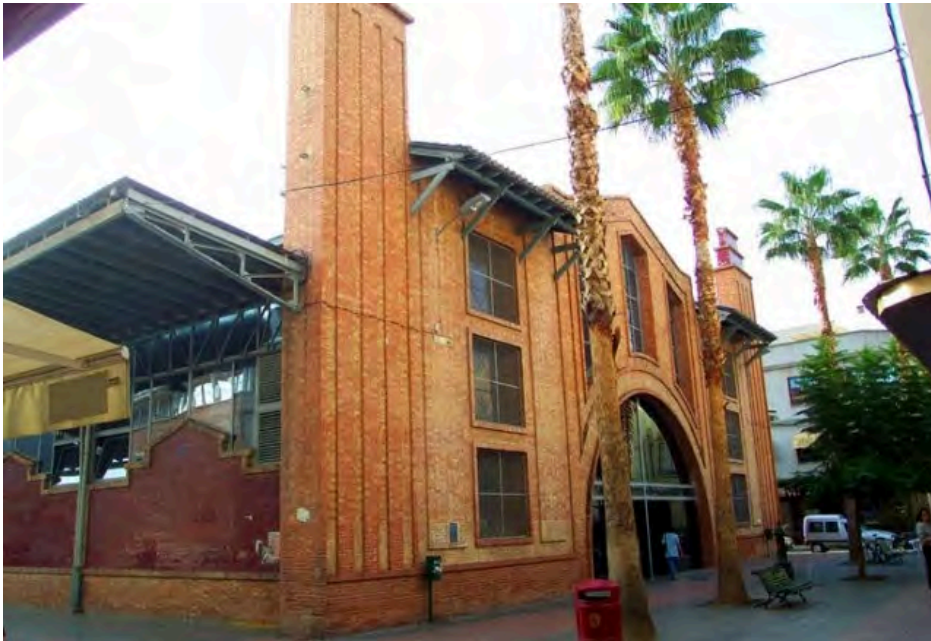
Fotografía de la fachada principal
