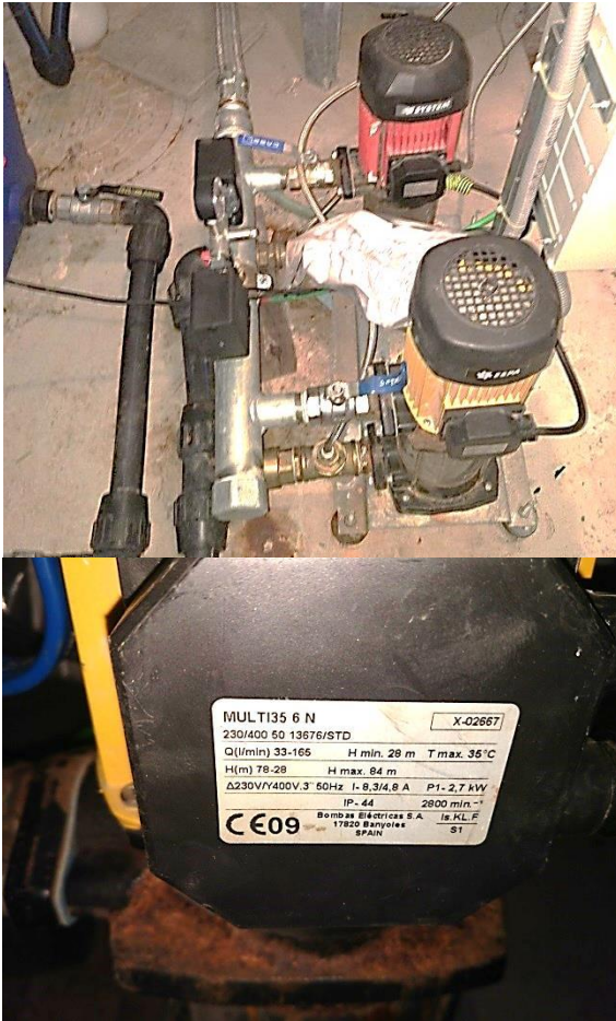
Fig. 42, 43 i 44 (Font pròpia): Fotografies de l'equip de pressió per a l'aigua potable del Mercat. Es tracta de dues bombes de pressió de 2'7 kW cadascuna funcionant en paral·lel i de forma alternativa. També consta de calderí de 100 L i depòsits de polietilè amb una capacitat total aproximada de 2000 litres.
