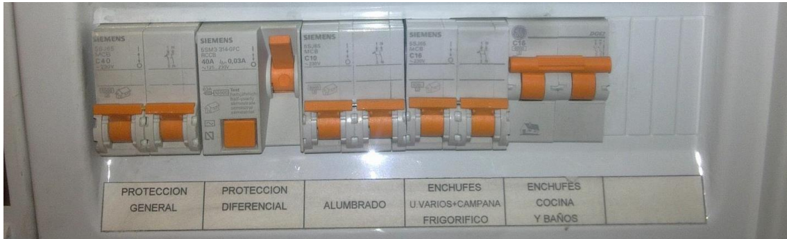
Fig. 160 ( www.centramultiservicios.com ): Exemple de quadre correctament identificat i etiquetat, per a un cas domèstic.
