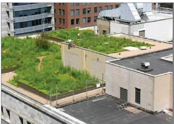
Fig. 84 i 85: ( www.pthorticulture.com ) : Foto de l'esquerra : Sostre Verd de Chicago City Hall Font: Informe de Pla d'Acció pel Clima de Chicago. Foto de la dreta: Imatge infraroja del sostre verd de l'Ajuntament Chicago amb tecnologia de detecció de calor, mostra en un dia típic, el sostre verd Ajuntament Chicago és de fins a 43°C més fred que el sostre convencional contigu.
