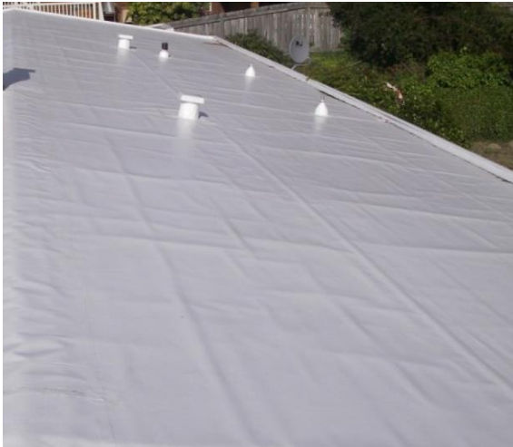
Fig. 78 ( www.pinturasarenas.es ): Aspecte del acabat d'una coberta inclinada reflectant.
