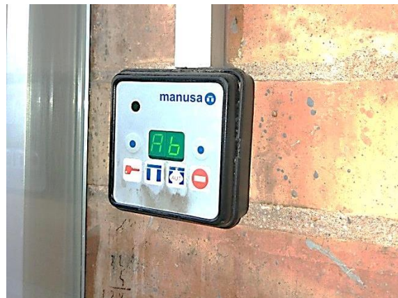
Fig. 31 (Font pròpia): Selector Óptima de la porta ubicada al C/ Cristòfol Colom en mode "Ab" (Abierto). En aquest moment la climatització estava apagada.
