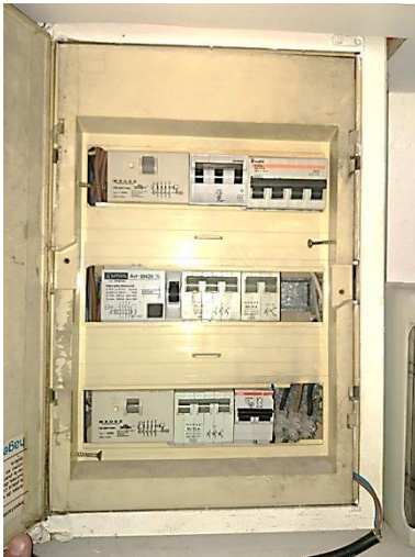
Fig. 25 (Font pròpia): Quadre general de protecció (CGP) de la xarxa monofàsica del Mercat
