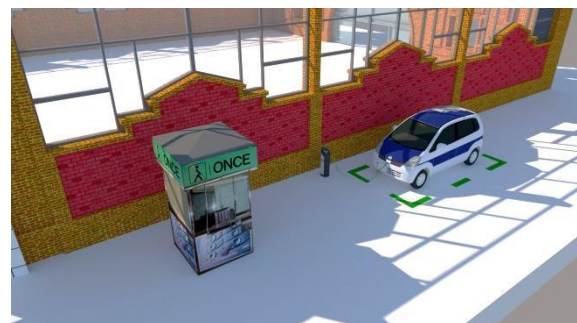
Fig. 159 (Font pròpia): Simulació de l'aspecte d'un vehicle elèctric càrregant les bateries al SAVE del Mercat Central. S'aprecia el SAVE i les marques viàries per al lloc d'aparcament destinat a l'ús de la recàrrega elèctrica.
