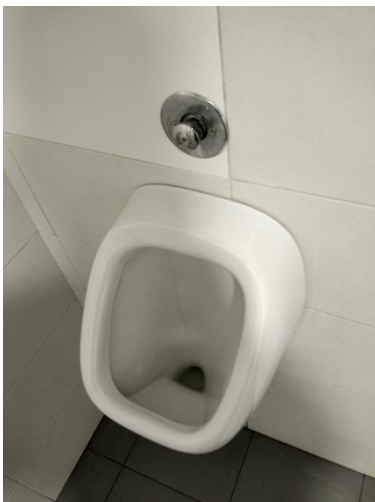
Fig. 54 (Font pròpia): Urinari bany homes amb fluxòmetre.
