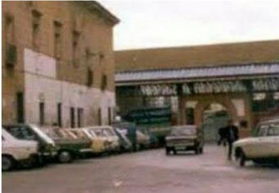
Fig. 21 ( www.facebook.com ): Fotografia prèvia als anys 80. Es pot comprovar que el color de la coberta es marró, segurament pels líquens que poblarien el fibrociment.
