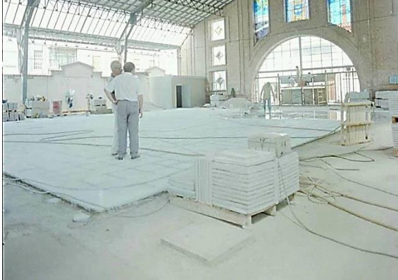
Fig. 24 ( www.facebook.com ): Fotografia de la reforma dels anys 80 on s'aprecia el paviment i la solera de formigó inferior.
